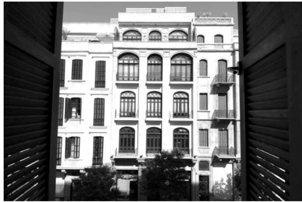
Un immeuble de la rue Foch, dans le centre-ville de Beyrouth, rénové par l'architecte.
